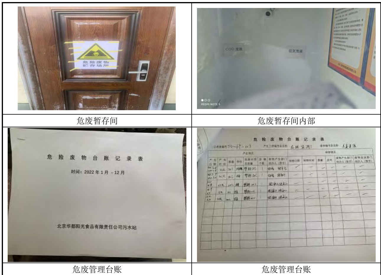
图 4.1-4 危险废物治理设施照片
